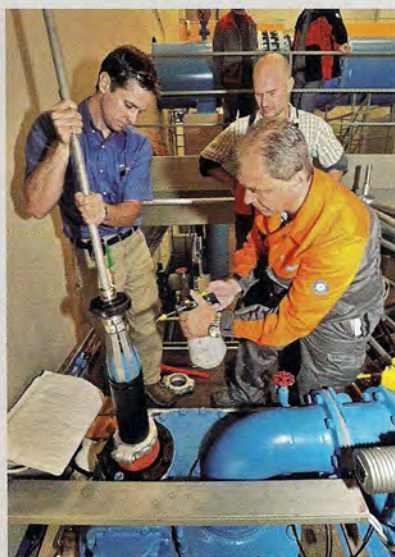
BILD 3: Einführung des SmartBalls™ in die Leitung über ein Entlüftungsventil im Hochbehälter (Foto: Felix)
