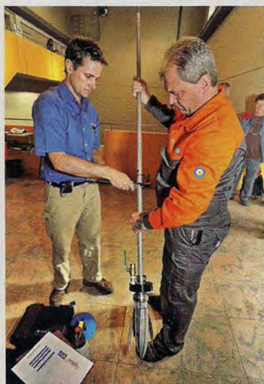
BILD 2: Mit Hilfe einer speziellen Vorrichtung kann der SmartBall™ leicht in die Leitung eingebracht werden (Foto: Felix)
